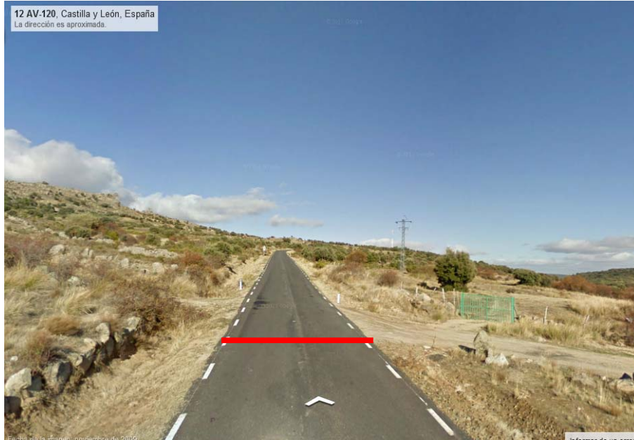
Salida Tramo A: Carretera AV-120 km 4,200
