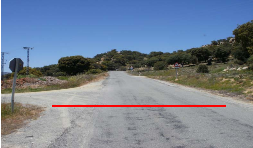
Salida Tramo C: Carretera AV-P-610 Km 0,300
