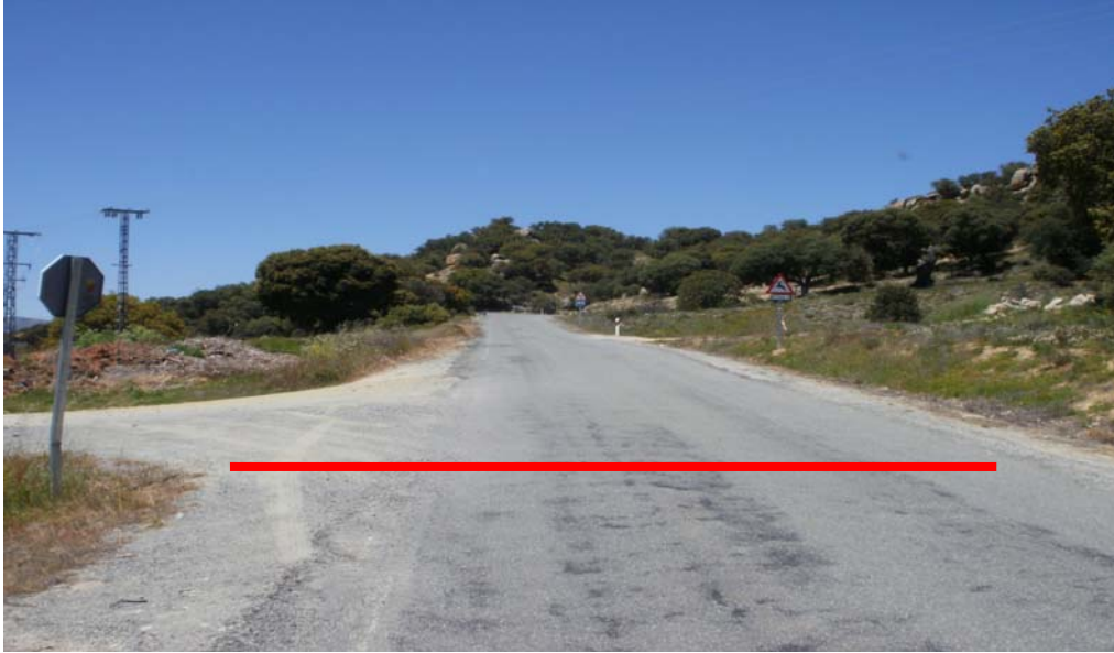
Salida Tramo C: Carretera AV-P-610 Km 0,300
