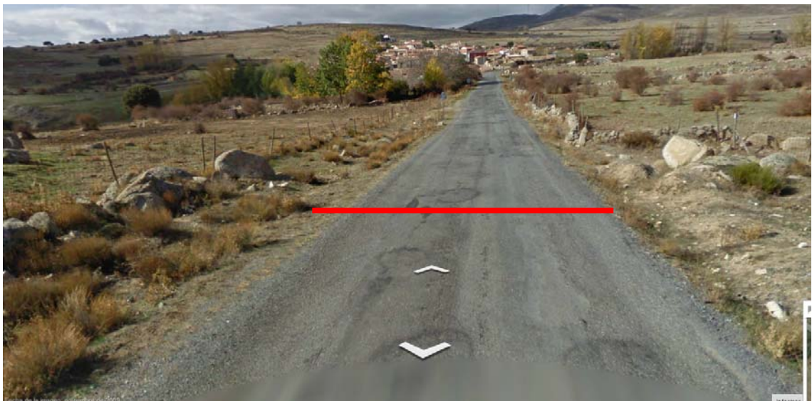
Llegada Tramo C: Carretera AV-P-610 km 6,400
