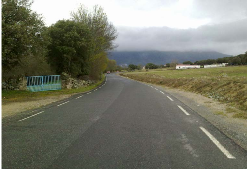
Salida tramo B , pk 8,100 AV-P -417
