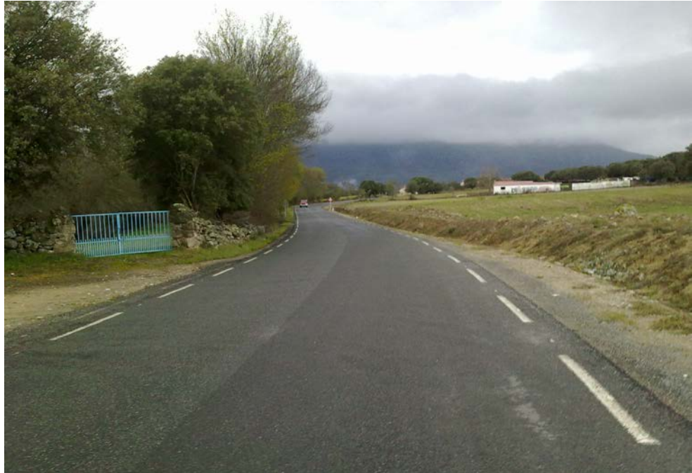
Salida tramo D , pk 8,100 AV-P -417
