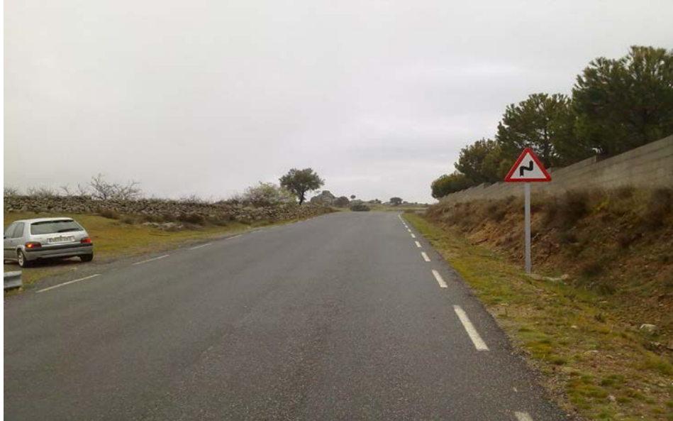
Salida tramo A pk 0,600 AV-P-417
