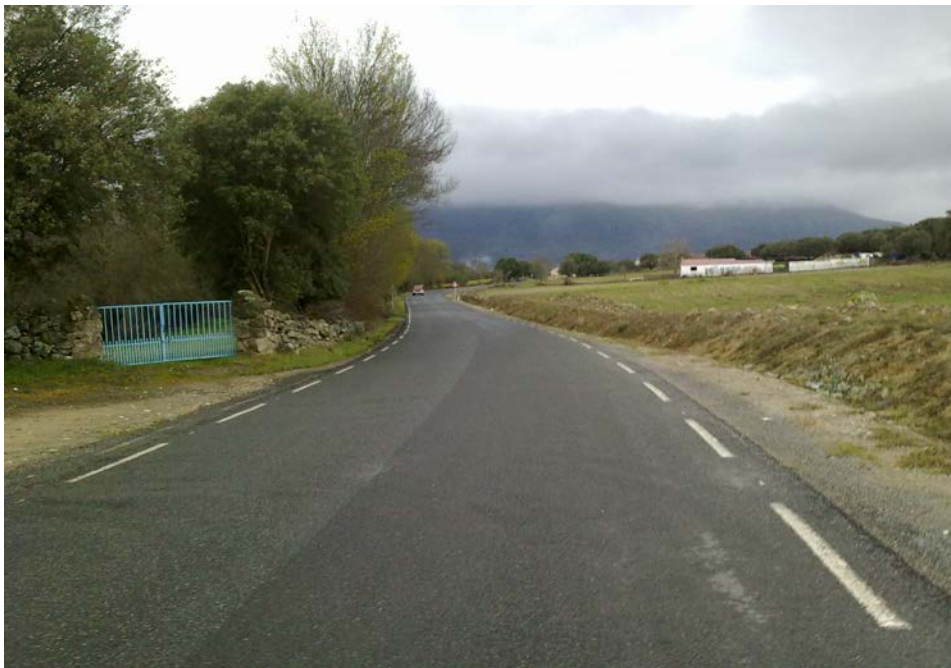
Llegada tramo C pk 8,100 AV-P-417
