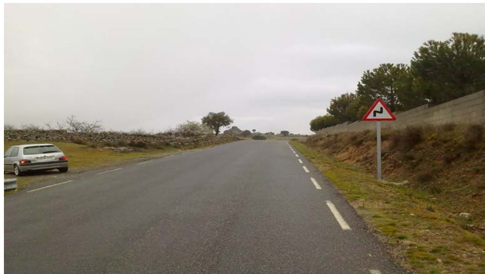
Llegada tramo D, pk 0,600 AV-P-417
