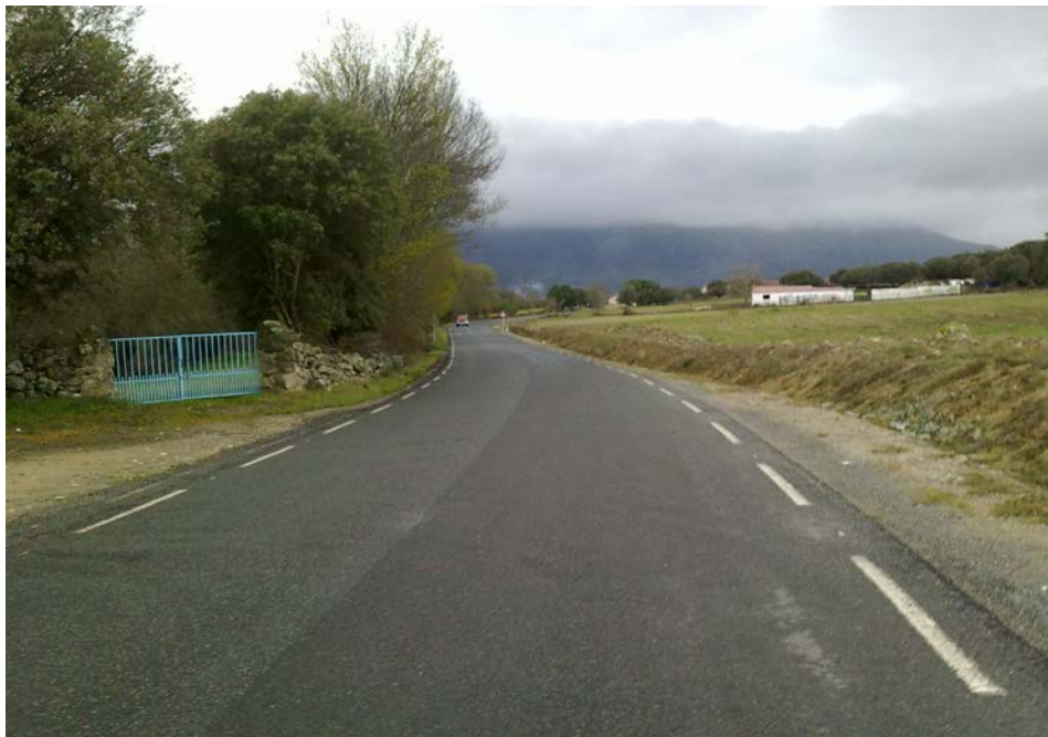
Llegada tramo A pk 8,100 AV-P-417
